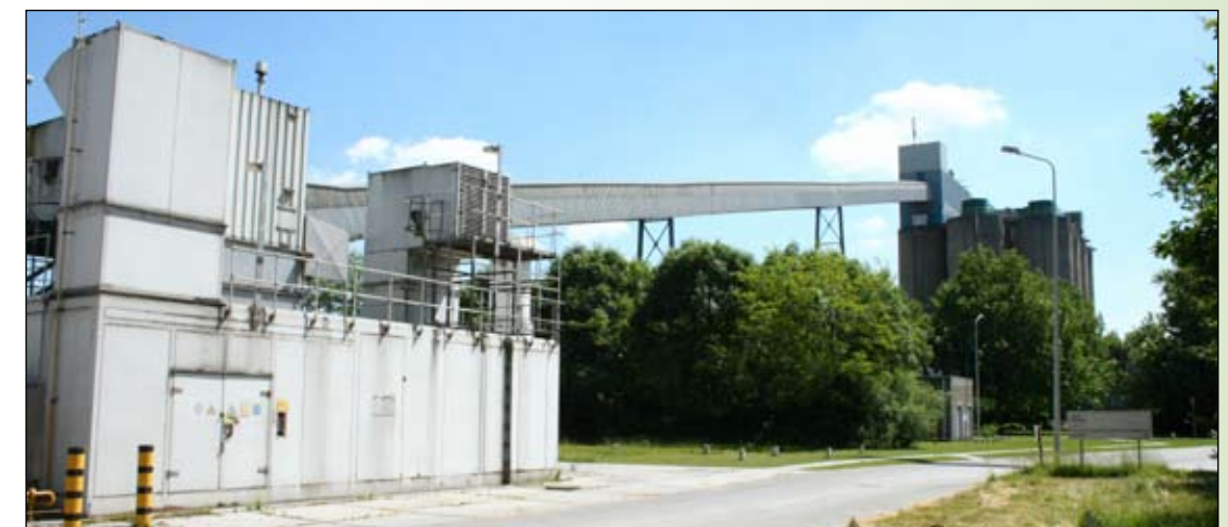
250 meter transportband van de maal- naar de droogafdeling
